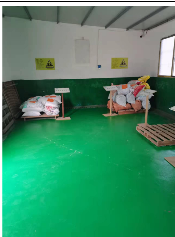
图4-5 危废间防渗地面
