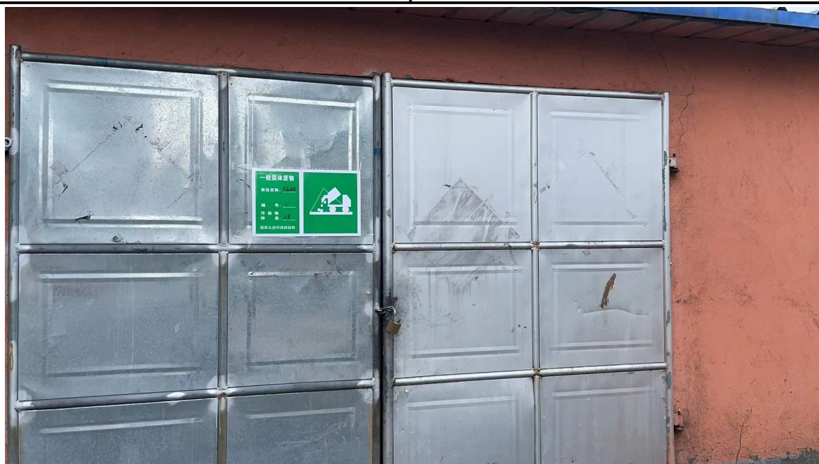
图4-10 一般固废暂存间
