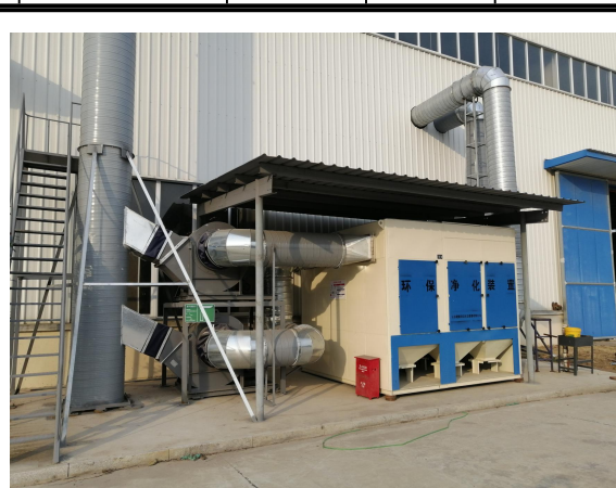
图4-3 滤筒除尘器
