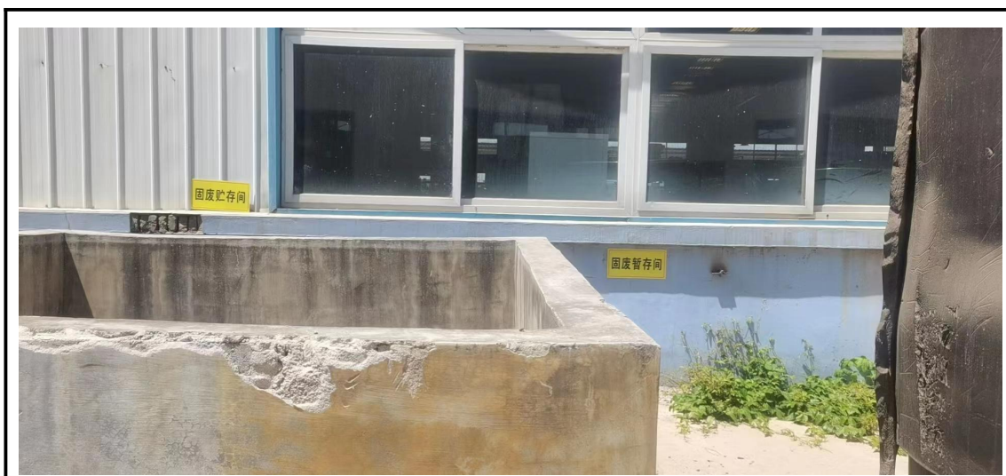
图4-9 一般固废暂存间
